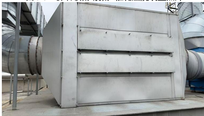
图 3-3 沸石吸附-脱附+催化燃烧装置照片
