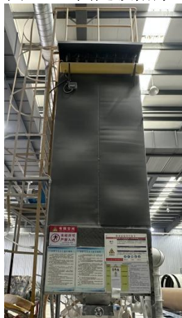
图 3-5 布袋除尘装置照片
