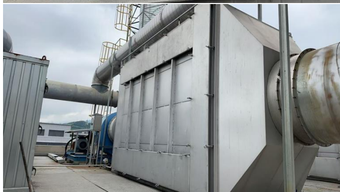
图 3-4 固定吸附床（活性炭吸附装置）照片
