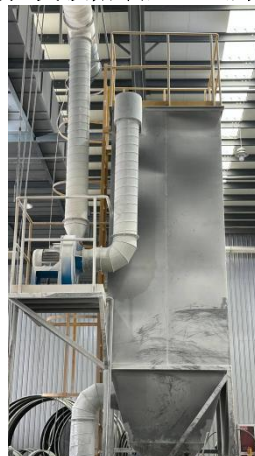
图 3-5 布袋除尘装置照片
