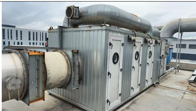
图 3-3 沸石吸附-脱附+催化燃烧装置照片
