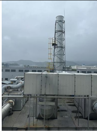
图 3-6 DA001 排气筒照片
