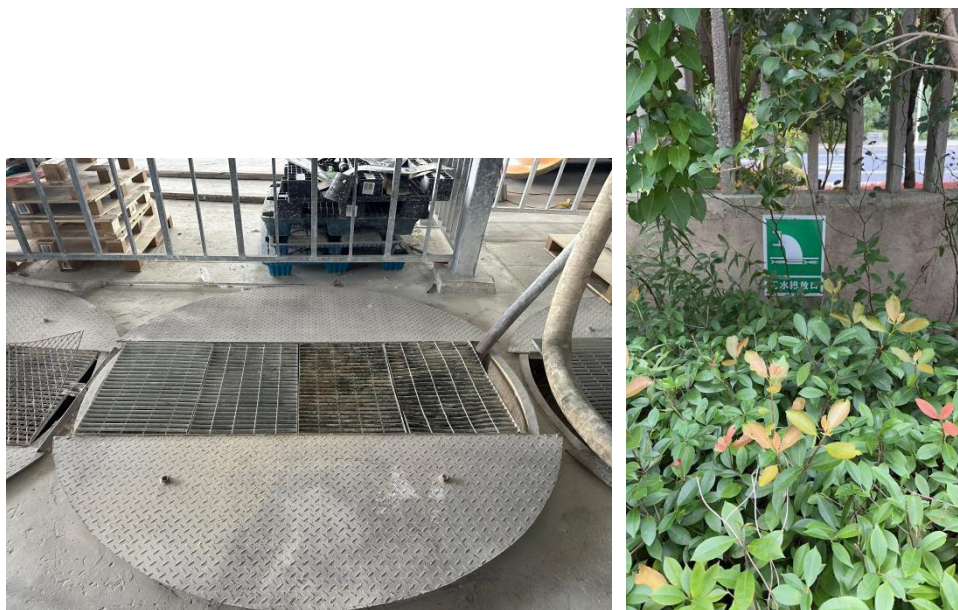
图 3-1 车间沉淀池、污水排放口标牌照片
